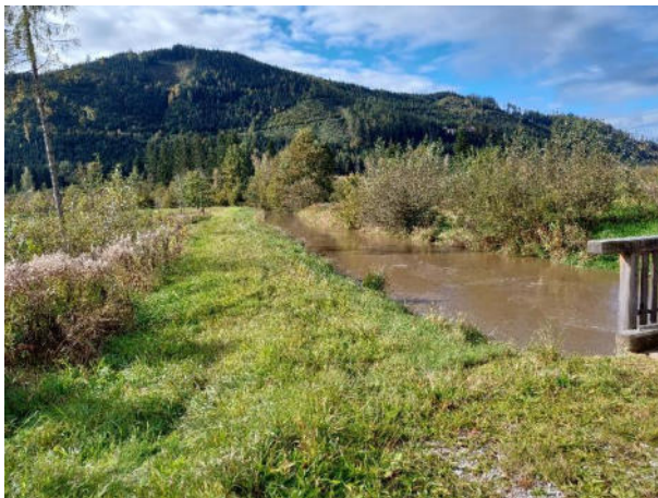
Abbildung 5: Oberwasserkanal der Pöls (Foto: Kofler Umweltmanagement ZT GmbH 2024)
